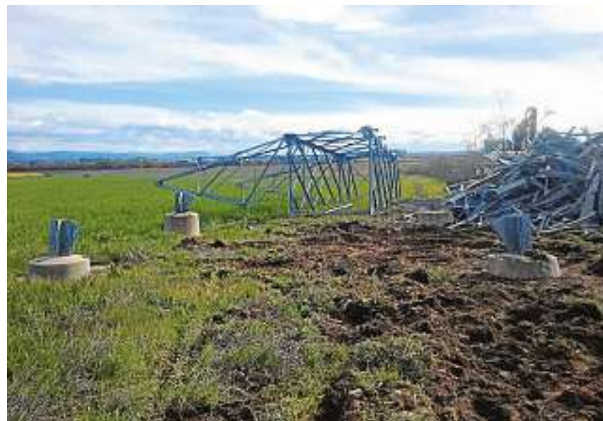
Una de las torretas completamente desmontada
