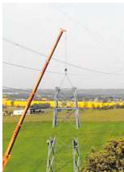
Una gran grúa para el desmontaje
